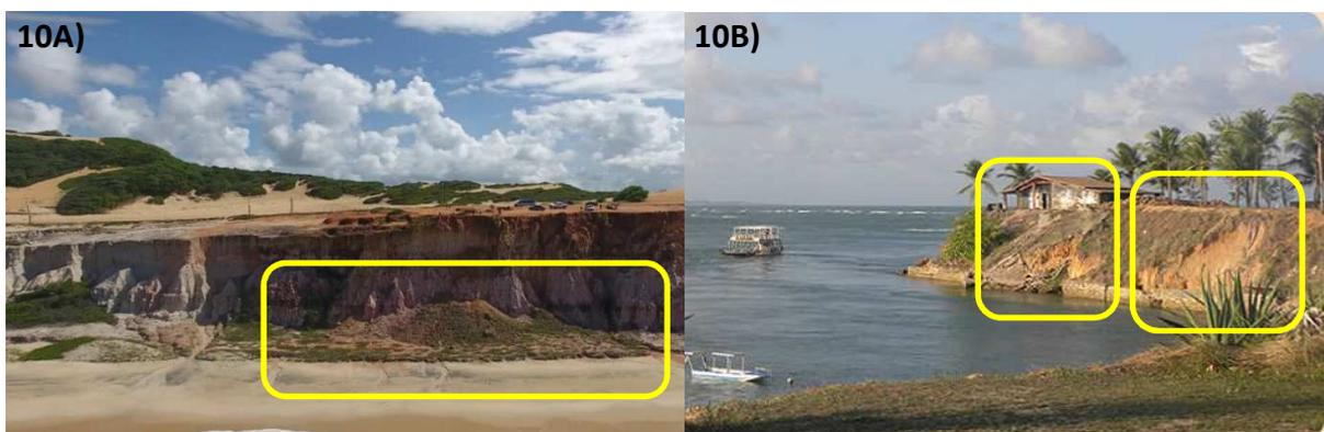
Figura 10 – A) Áreas com risco de deslizamento, onde o recuo erosivo da falésia/arriba poderá alcançar a estrada que se encontra sobre a mesma em Tibau do Sul. B) Deslizamento da falésia/arriba danificando a estrutura de contenção que protegia a base da mesma e aumentando o risco de desmoronamento das ocupações presentes na borda da mesma em Tibau do Sul. Fonte – IDEMA, 2008.
