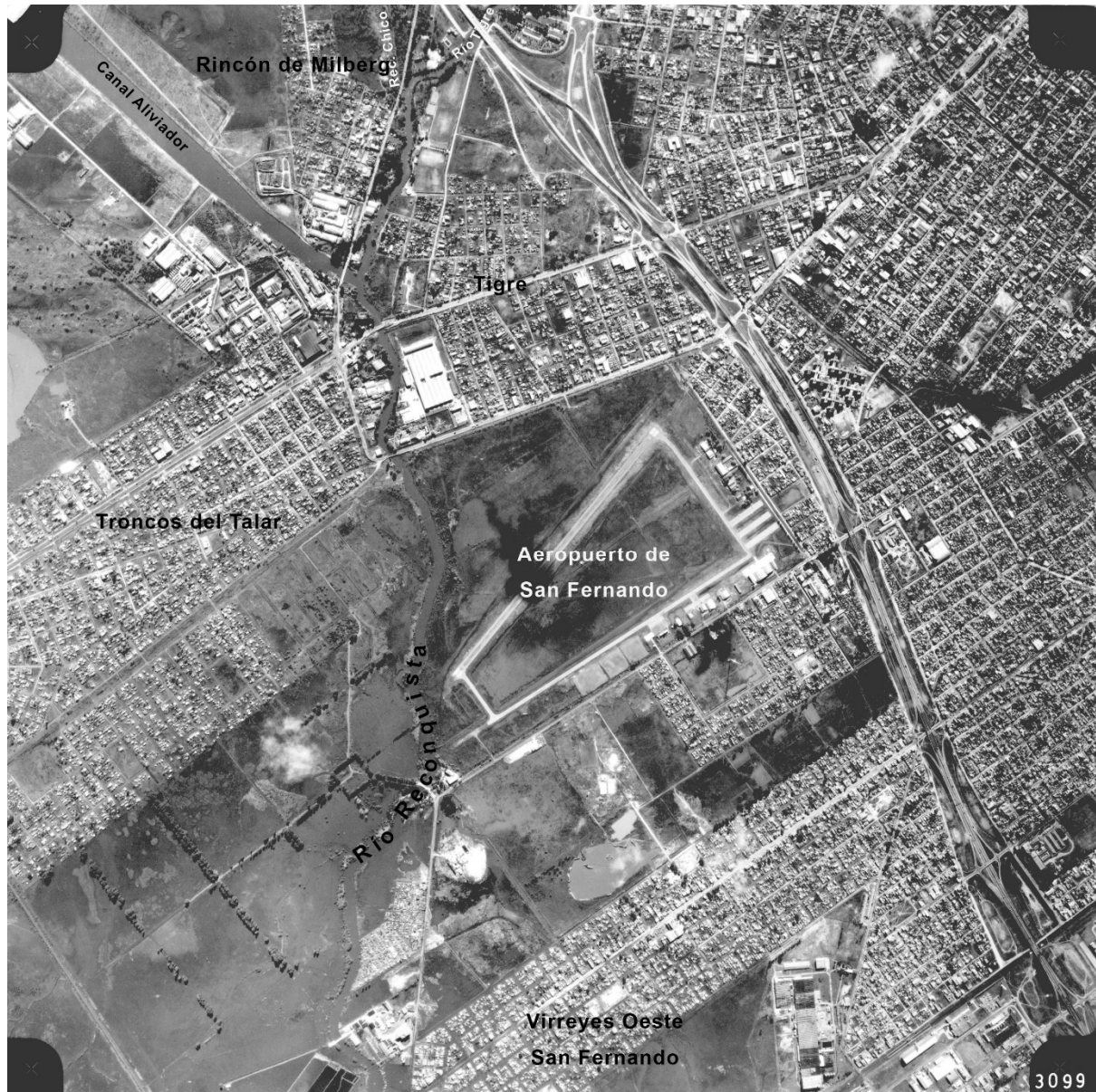
Figura 9 - Foto aérea de la zona de Rincon de Milberg-Tigre-Troncos del Talar durante la inundación de 1985. Fuente: Dirección de Hidráulica, Provincia de Buenos Aires.
