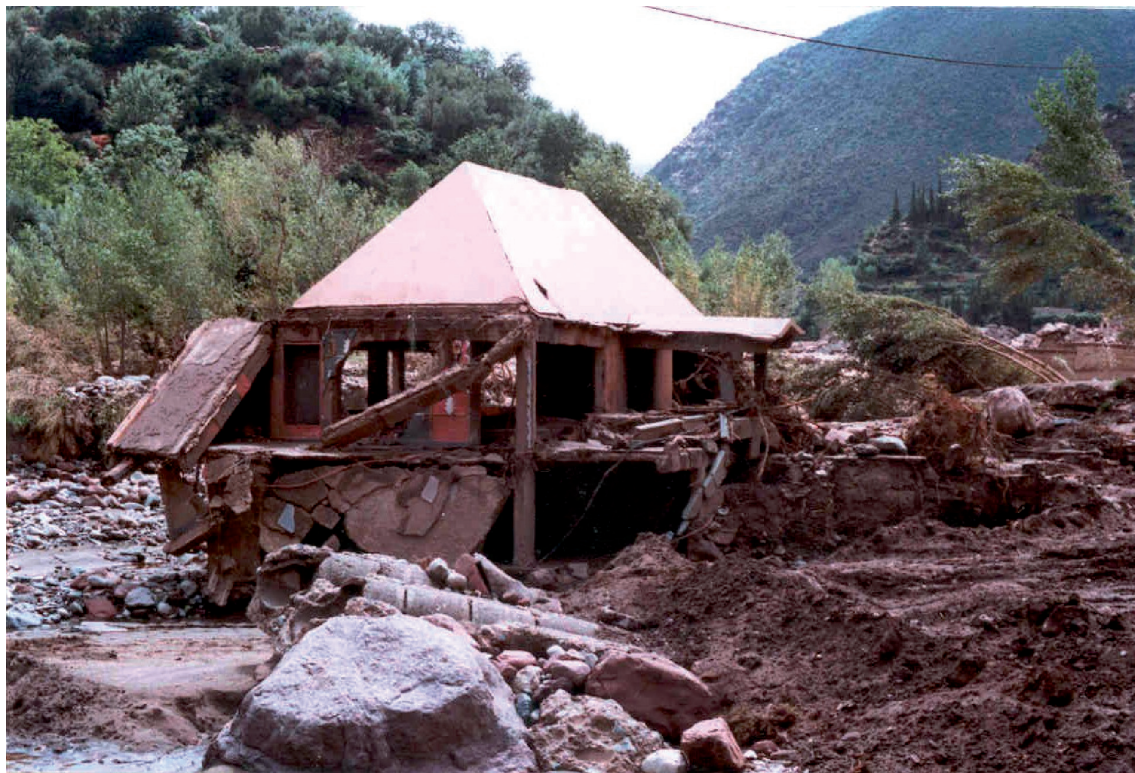
Fig. 12 – Habitation édifée près du lit de l'oued et détruite par la crue du 17 août 1995 (Source: Agence de Bassin Hydraulique de Tensift).
