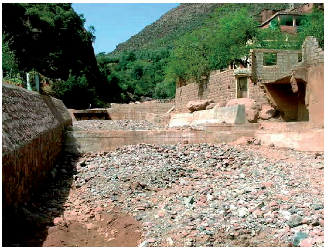
Fig. 15 – Seuils de stabilisation de Tighzirt et comblements par la charge solide des crues.
